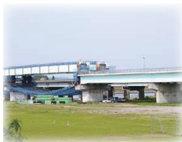
↓ 工事中の日向大橋(H27.4)
