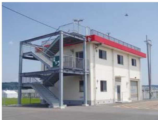
図 4-21 横江地区複合型津波避難施設
