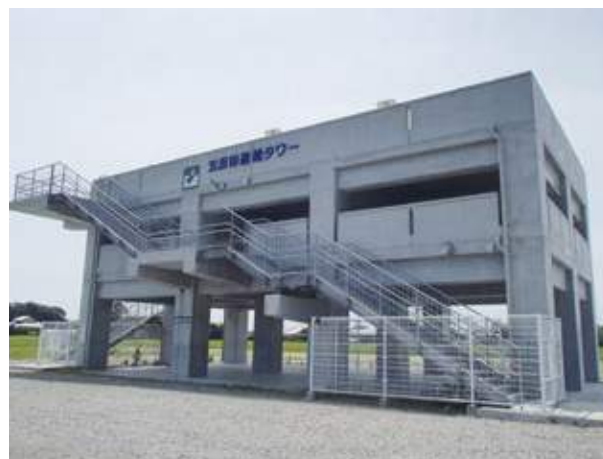
図 4-22 五反田地区津波避難タワー
