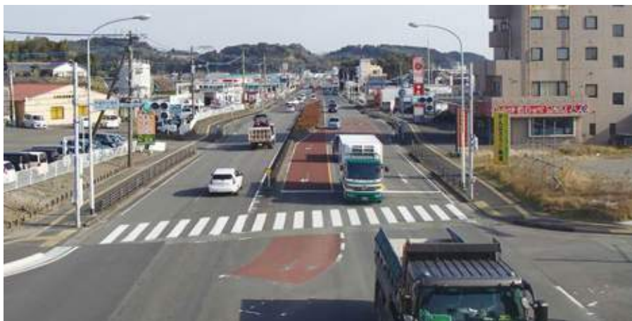
図 4-8 整備された国道 10 号の 4 車線化
