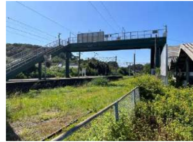
▲JR日向新富駅 跨線橋(現況)
