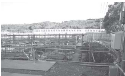
新田小学校校舎建設現場
