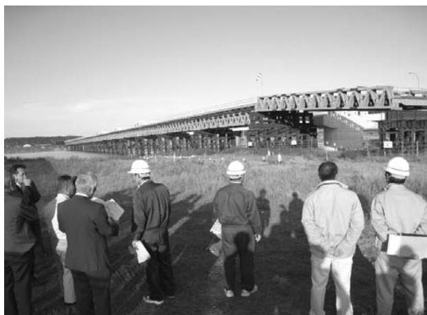
日向大橋上流橋の工事現場
