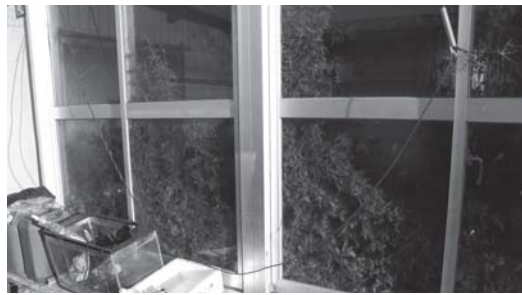
成法寺住宅の空き家 部屋に木が？
