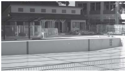
富田小プールきれいに改装中
