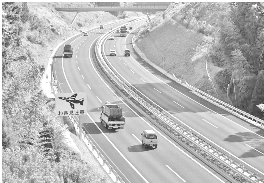
高速道路の様子 (十文字地区)
