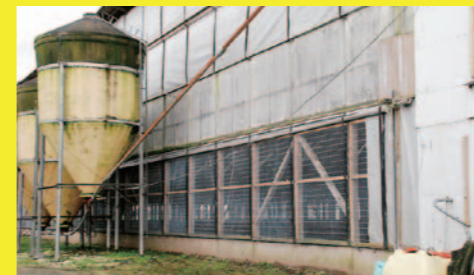
補助事業による防鳥ネット設置
