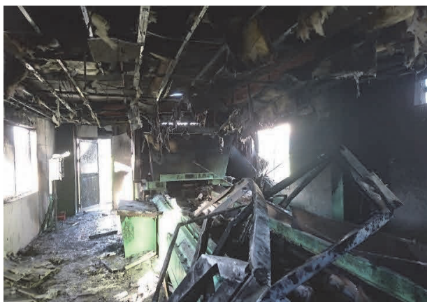
充電式小型家電の発火が原因でリサイクル工場の 建屋・設備が焼けてしまった事例
