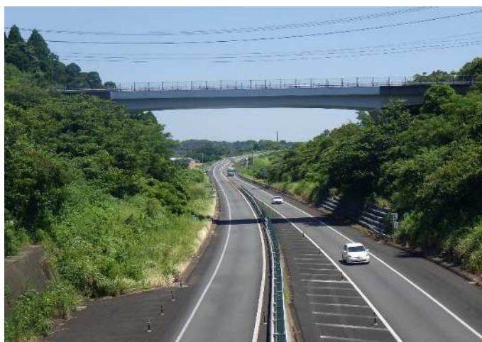
図 10 道路を跨ぐ橋梁の例（新富町管理 駒取場橋）
