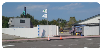
認定こども園建設現場
