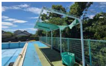
新田中プールサンシェード修繕
