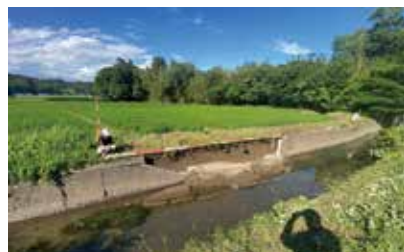
金丸幹線水路復旧工事
