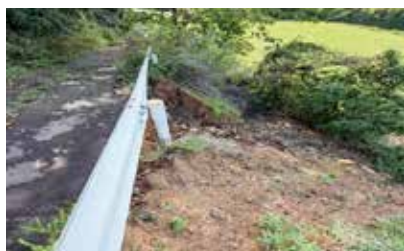
黒坂3号線法面復旧工事
