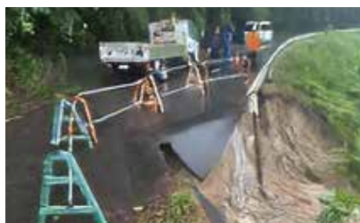
平伊倉～三財原線法面復旧工事
