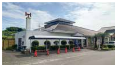
老朽化したボイラー設備更新
