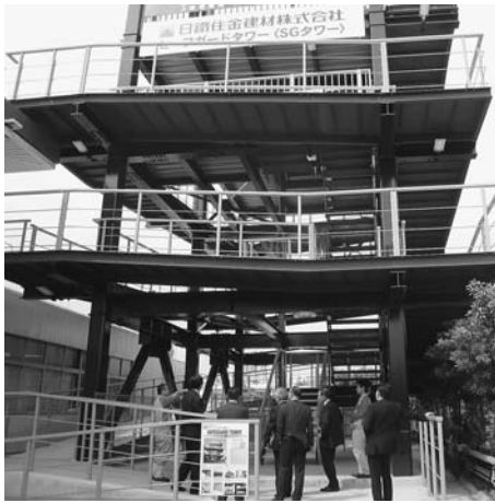
高台のない地域に望まれる 避難タワー
