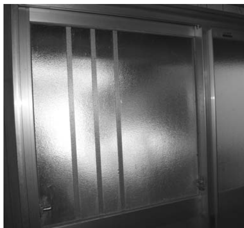
防音工事で設置されたサッシ
