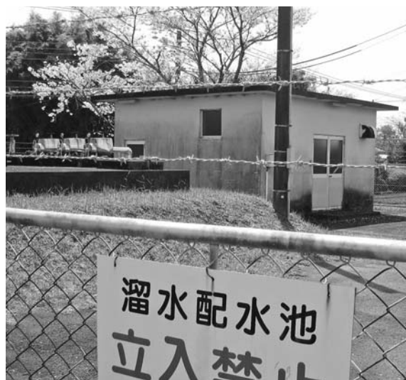
新しくなる溜水配水池
