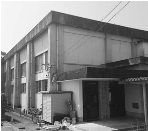
P T A から建て替えが望まれている富田小学校講堂
