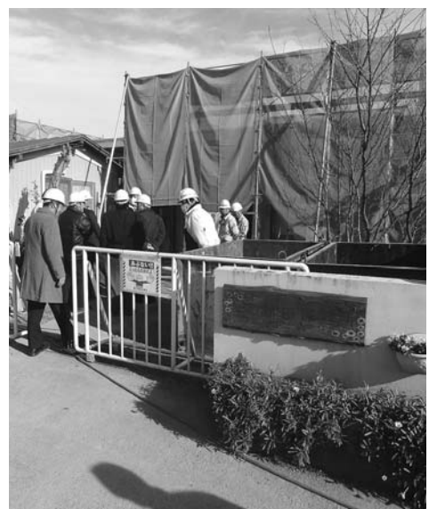
新田保育所改修工事の様子
