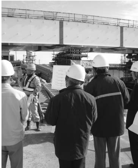
日向大橋建設を視察中の様子
