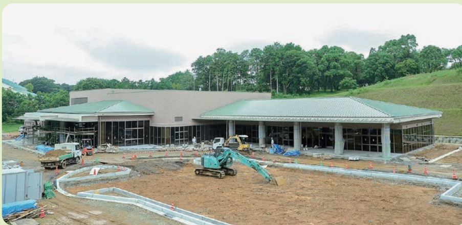
↑ 建設中の「再生の杜」（7月初旬撮影）
