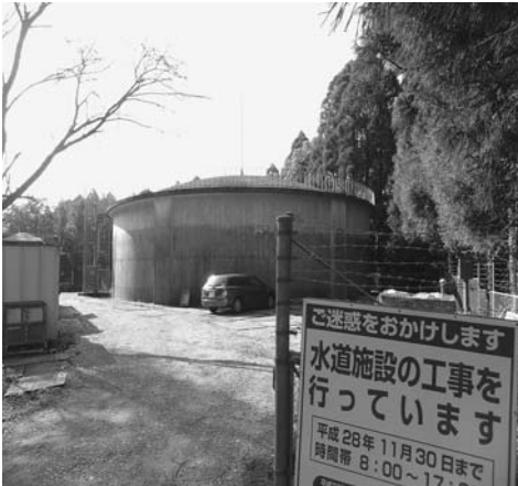
築造工事が進む弁指配水池
