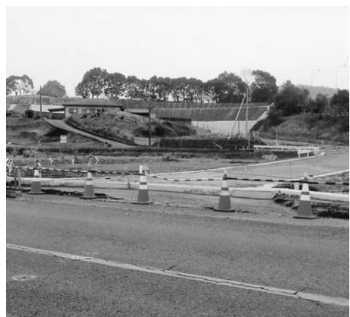
建設中の山之口スマートIC
