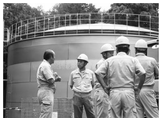
増設された弁指貯水池
