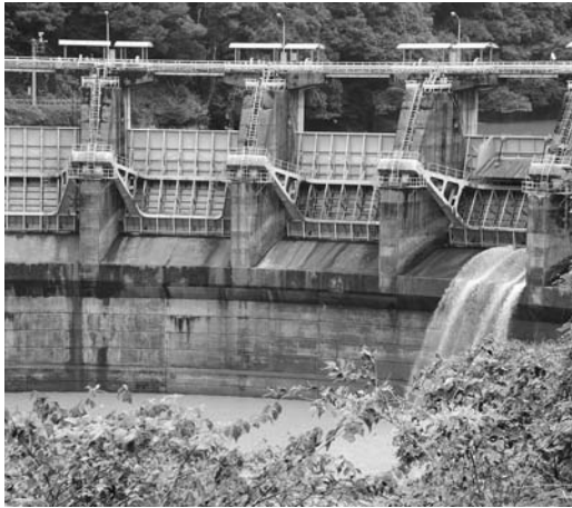
放流中の杉安ダム
