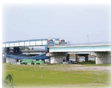
↓ 工事中の日向大橋(H27.4)
