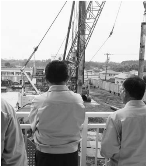
上新田小学校建設現場視察
