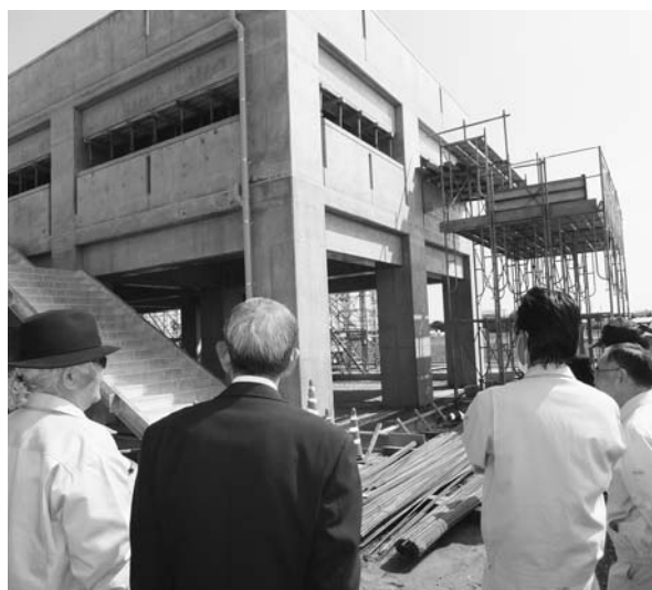
建設中の津波避難タワー (五反田地区)
