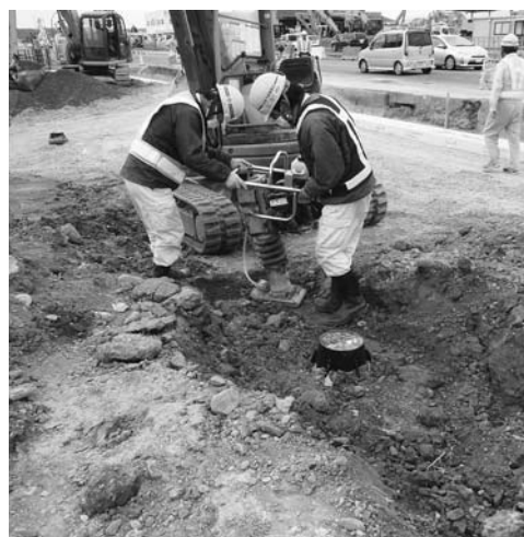
道路改良工事に併せた配水管布設工事
