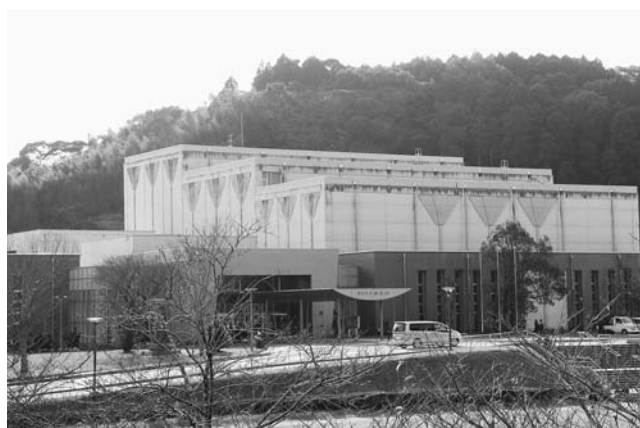
照明卓改修工事が 行われる文化会館
