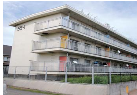
改修工事を行う住宅
