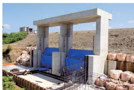
新田地区に建設中の放水路
