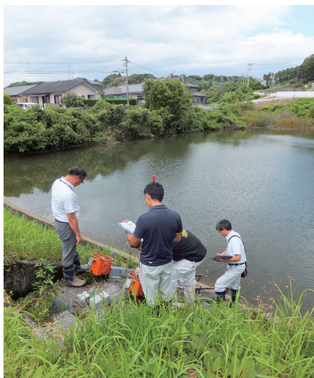
適正に管理点検される「ため池」
