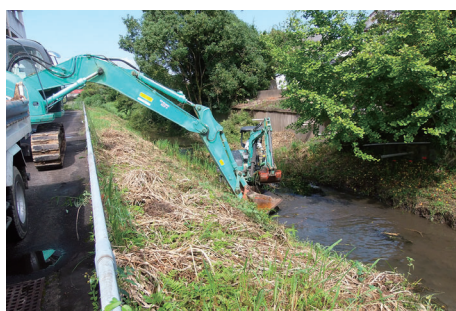
排水路の土砂撤去
