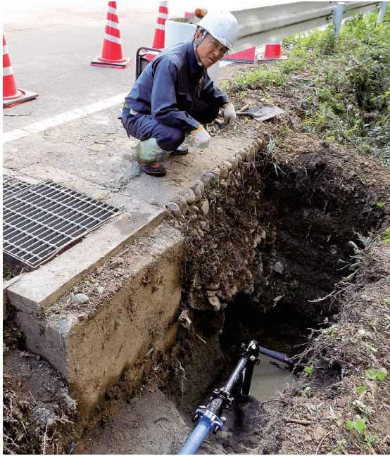
南原線配水管布設工事 (弁指地区南側の県道)
