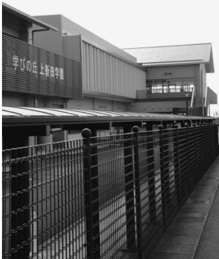
中学校南に併設された 上新田小学校校舎
