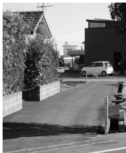
整備された生活道路（舟津地区）
