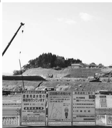
国富町に建設中のスマートIC
