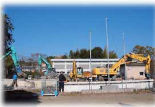
解体中の旧上新田小学校校舎
