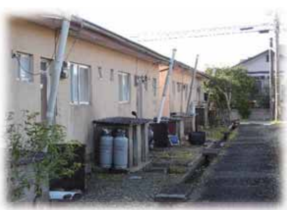
町営桜木住宅
