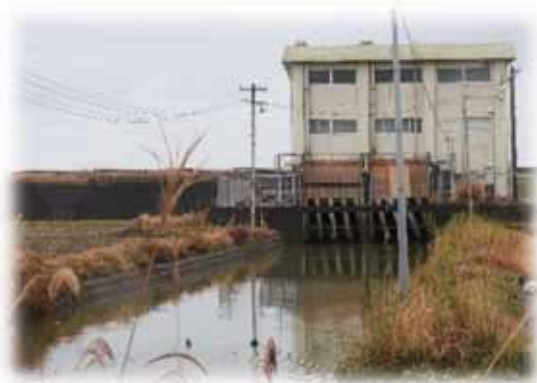
大雨対策は万全か（横江排水機場）
