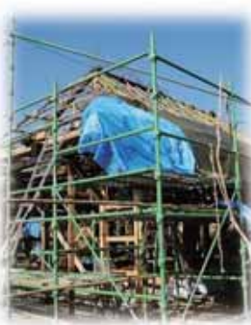
移設中の古民家
