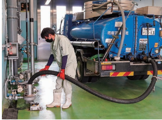
（有）新富衛生社がし尿や浄化槽から回収した汚泥は、においを屋外に漏らさないようポンプを通して受入槽に投入。
