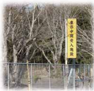
施設移転も含め改修が必要では
