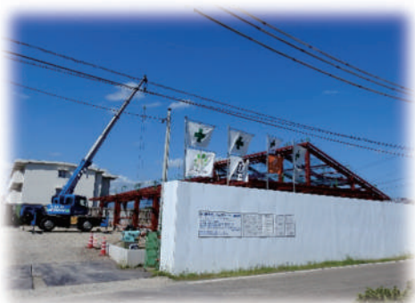
新田コミュニティセンター工事現場
