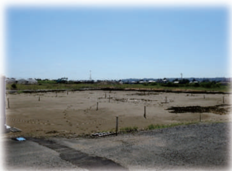
成法寺住宅跡地は敷き均し工事中
