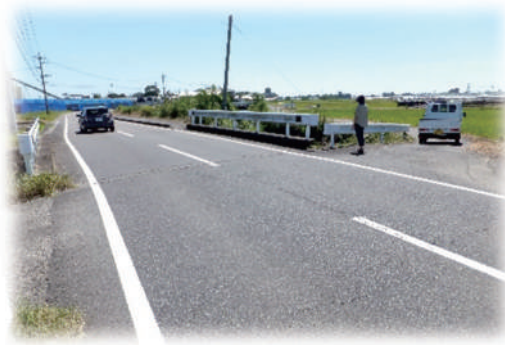
歩道橋整備が待たれる堂川橋
