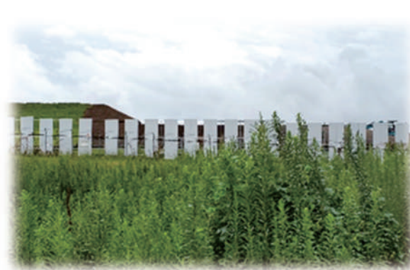
地上騒音対策で造成中の防音堤
