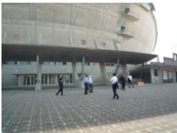
改修費用に防衛関連補助金を利用 こまつドーム（生涯学習センター）
