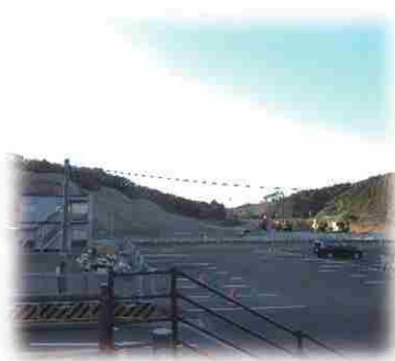
新富町文化会館西側の工事現場
