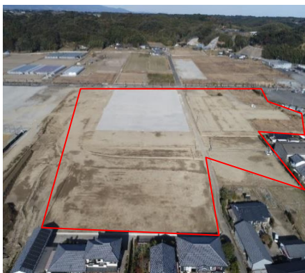
総事業費 6億2,066万円 屋外運動場用地の造成工事を行いました。完成は令和4年度末を予定しています。
