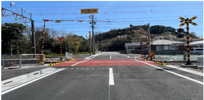
総事業費 6,417万円 改良された三納代踏切。利便性が向上しました。
