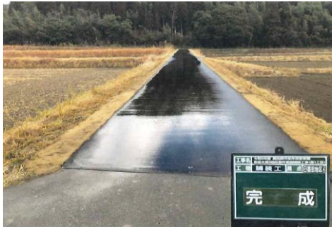
総事業費 2,024万円 農作業の効率化、利便性向上のため、農道の舗装を行いました。(写真は日置田付近)
