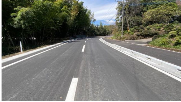
総事業費 2,827万円 改修された佐土原～木城線(写真は西畦原地区付近)
