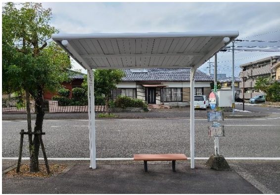
総事業費 447万円 八幡地区の富田八幡停留所に屋根を設置しました。
