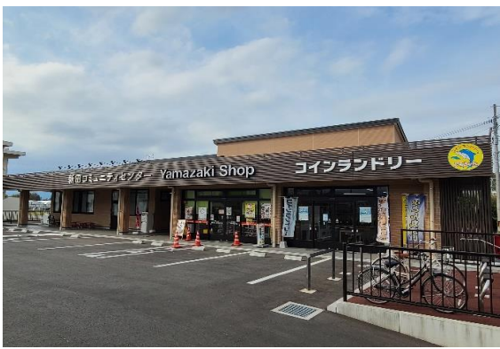
総事業費 2億5,504万円 新田公民館に新田支所、コンビニ、コインランドリーを併設したコミュニティセンターを建設しました。
