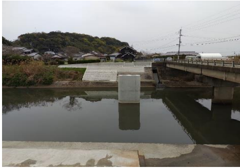
総事業費 3,058万円 歩道橋工事中の鬼付女橋(写真は鬼付女地区付近)
