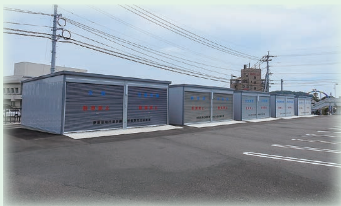
新しく整備された防災倉庫（役場駐車場内）
