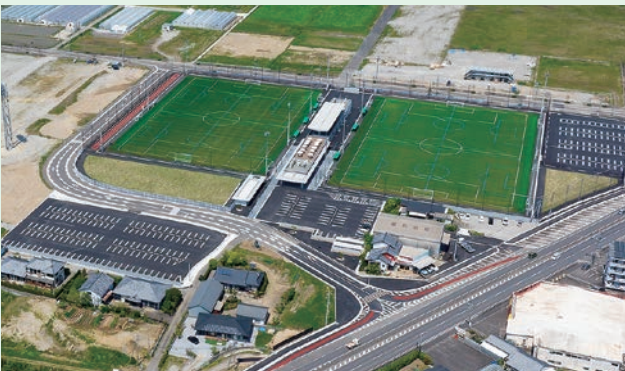
新富町フットボールセンター 予約も順調に埋まっているようです
