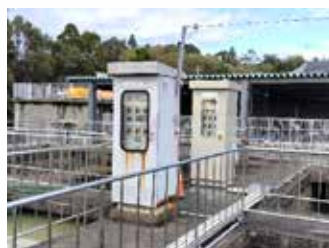
薄いグレーが旧現場操作盤、クリーム色が新現場操作盤です
