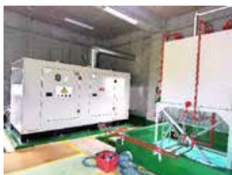
写真左側が発電機 右側は燃料タンク
