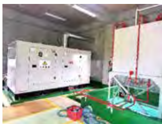
写真左側が発電機 右側は燃料タンク
