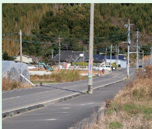
コンビニなど建設が進む
