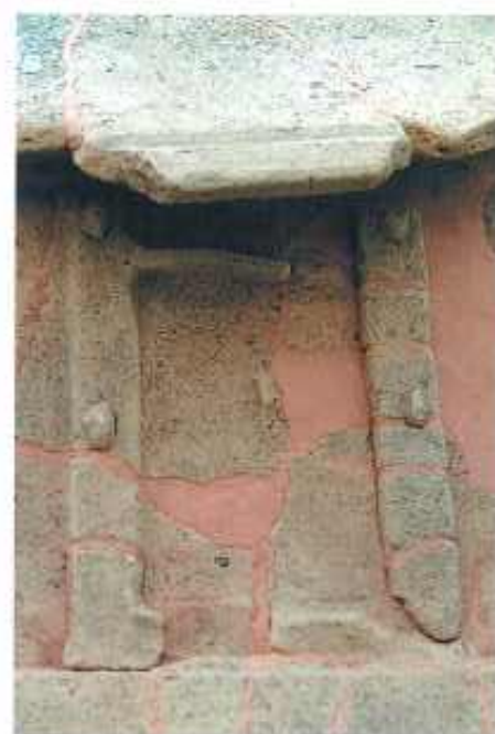
⑧倉庫風建物の扉
