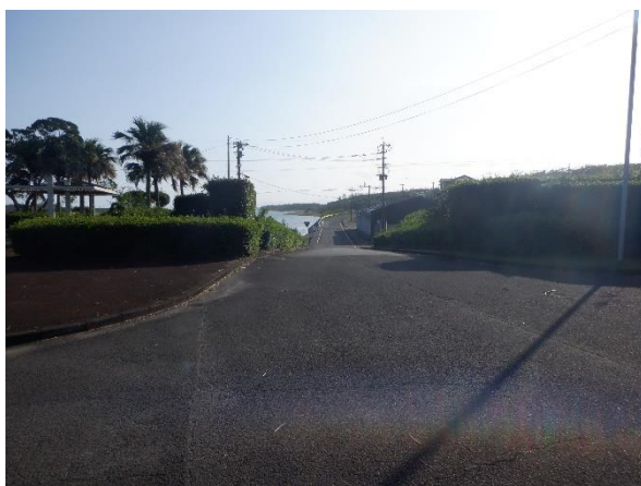
公園入口及び進入路
