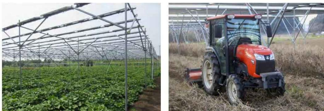
写真5 畑上部にパネル設置（左）とパネル下で耕運作業（右）
