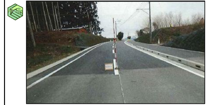
佐土原～木城線道路改修事業(防衛省 民生安定事業)
