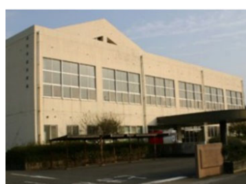
新富町西体育館
