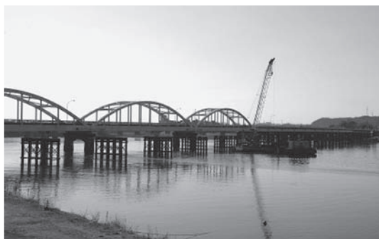
平成21年1月現在の工事状況
