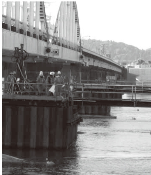
日向大橋上流橋の工事
