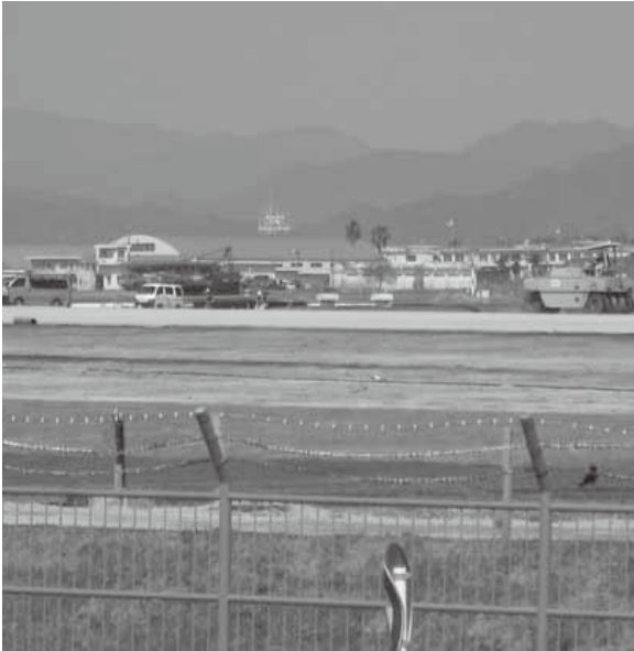
眺鷲台から見た仮滑走路工事
