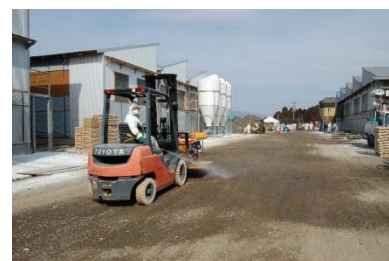
⑬散水作業
