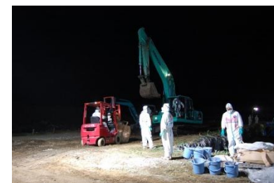
⑳夜間作業（埋却作業）
