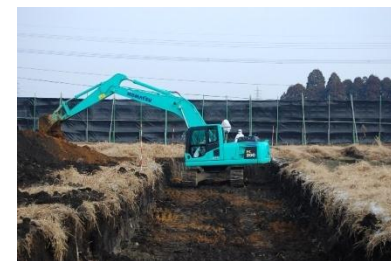
⑤埋却地の掘削作業
