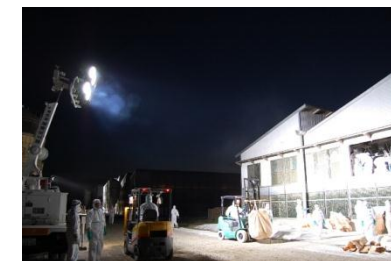
⑮投光器の基での夜間作業
