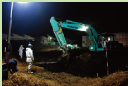
②町職員指揮により夜を徹して行われた埋却地の掘削作業
