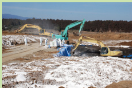
⑬フレコンバックの埋め戻し及び石灰散布作業
