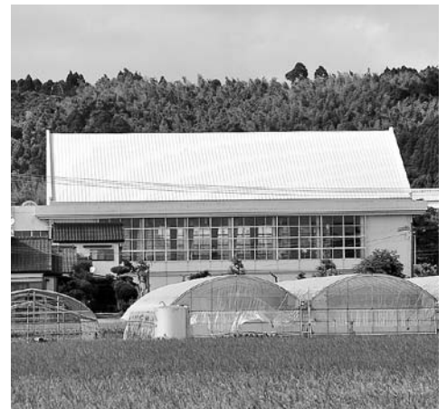
太陽光発電システム設置予定の西体育館
