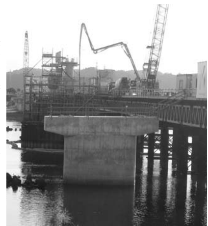
早期完成を要望しているが中々進まない上流側日向大橋の建設工事
